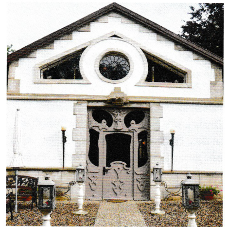
Schöne Fassade und einladender Eingangsbereich.
